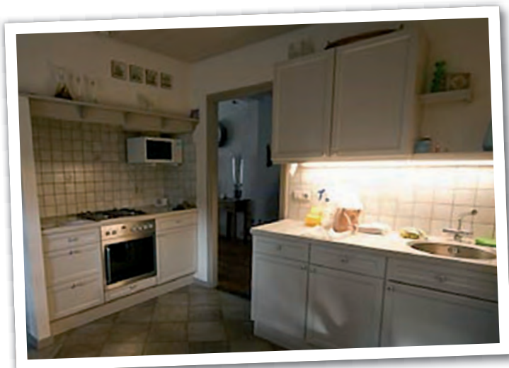
Zoals het absoluut 1 niet moet. Een slechte uitlijning, scheve muren, uit het verband getrokken.
